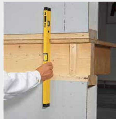
Afbeelding 4.10: Passtellen van de wandelementen
