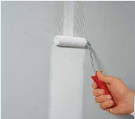
Afbeelding 3.14: Aanbrengen van de fermacell Powerpanel HD Wapeningslijm
