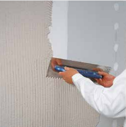
Afbeelding 3.16: Aanbrengen van de fermacell Powerpanel HD Basismortel
