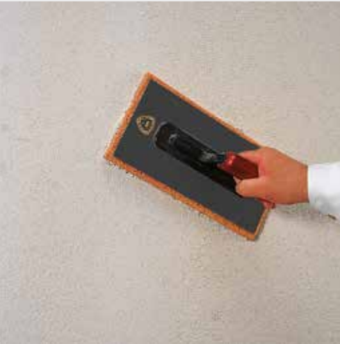
Afbeelding 3.17: Afwerking van de fermacell Powerpanel HD Basismortel
