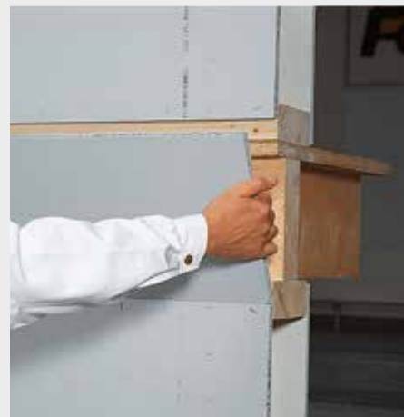
Afbeelding 4.11: Montage van de plaatstroken
