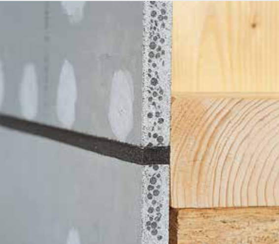
Afbeelding 2.3: Voeg bij vloerverbinding met gecompriëerd afdichtingsband tegen vocht beschermd
