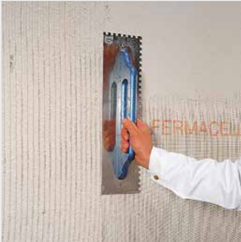
Afbeelding 3.19: Indrukken van de fermacell Powerpanel HD Wapeningsweefsel in het
