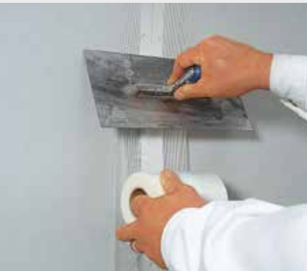
Afbeelding 3.13: Aanbrengen van de fermacell Powerpanel HD Wapeningsband
