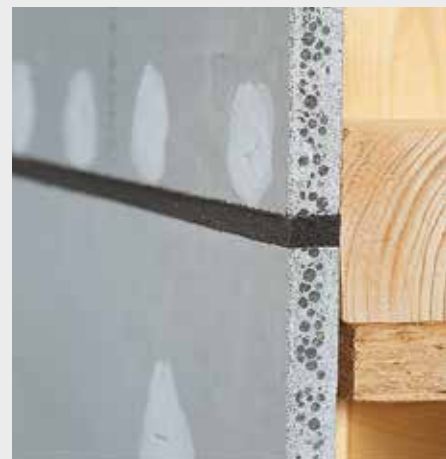
Afbeelding 4.13: Voorgecomprimeerd afdichtingsband voor tijdelijke bescherming tegen weersinvloeden
