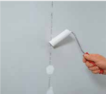
Afbeelding 3.15: Dekkend aantippen van de verbindingsmiddelen ter plaatse van de middenstijl
